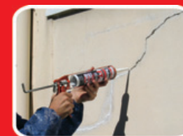
Vanjsko ispunjavanje pukotina
