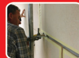
Ispunjavanje dilatacionih spojeva
