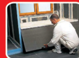
Lijepljenje „WEDI” ploča
