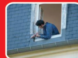
Brtvljenje krovnih prozora
