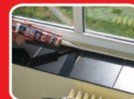
Unutrašnje brtvljenje prozora
