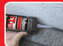
Brtvljenje vanjskih spojeva (betona)
