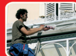
Saniranje prokišnjavanja
